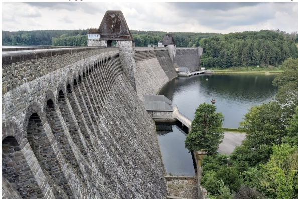
Den nyligen restaurerade dammen Möhntalsperre
