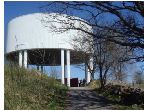
Vattentornet "Ekotemplet" ger ett härligt eko när man sjunger under det. Detta beror på att undersidan har formen av ett sfäriskt skal
